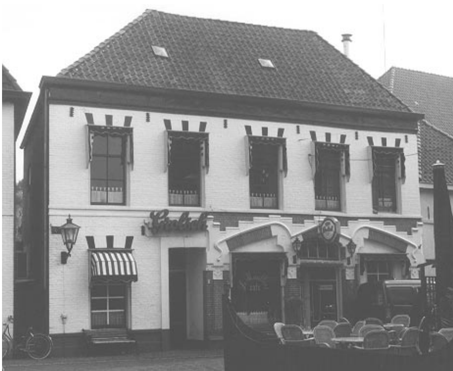
Clublokaal aan het Muraltplein in Borculo (bovenverdieping) (foto 2001)
