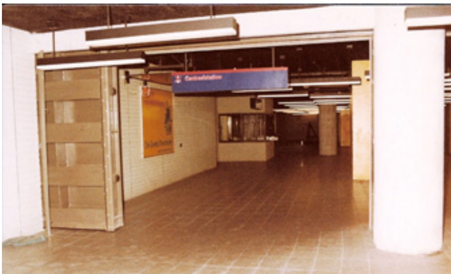
AFBEELDING 072 METROSTATION MET GASDEUREN
