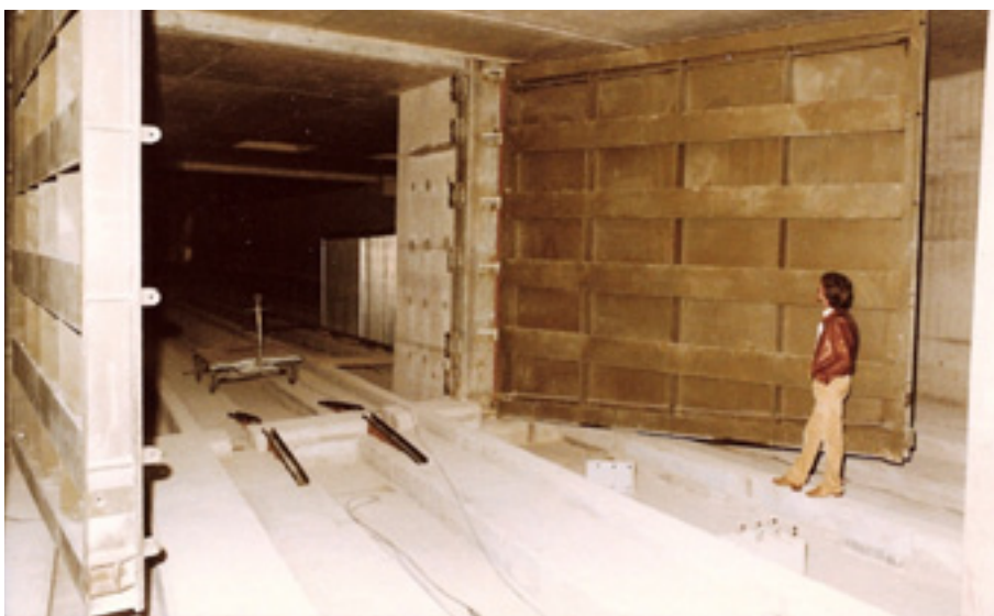
AFBEELDING 073 GASDEUREN IN EEN METROSTATION
